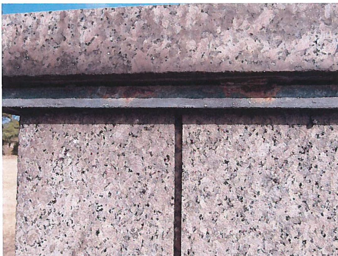
Obr. č. 20 Blok č. 2. Zkorodovaná plechová stříška.
