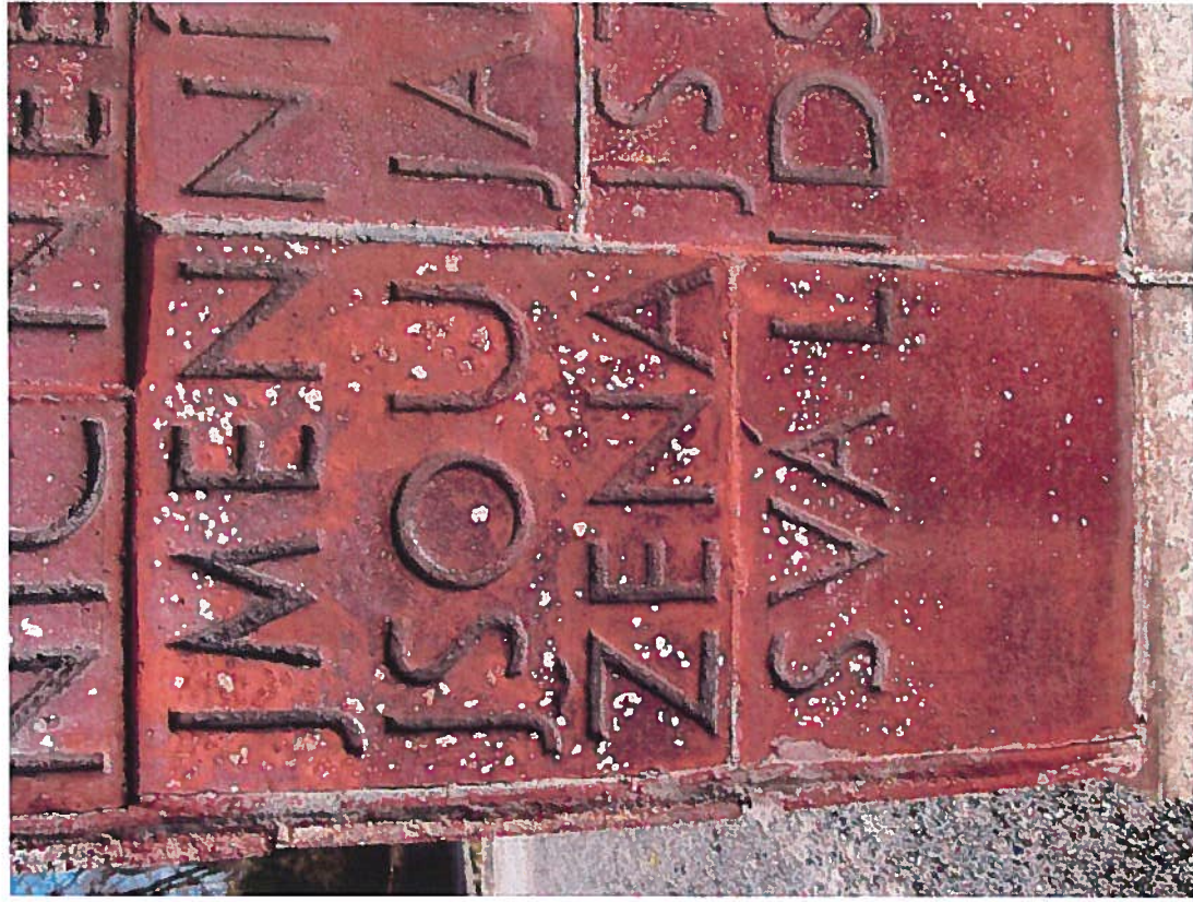
Obr. č. 17 a 18 Blok č. 2, jižní strana. Poškozený povrch keramiky, výkvěty síranových solí.
