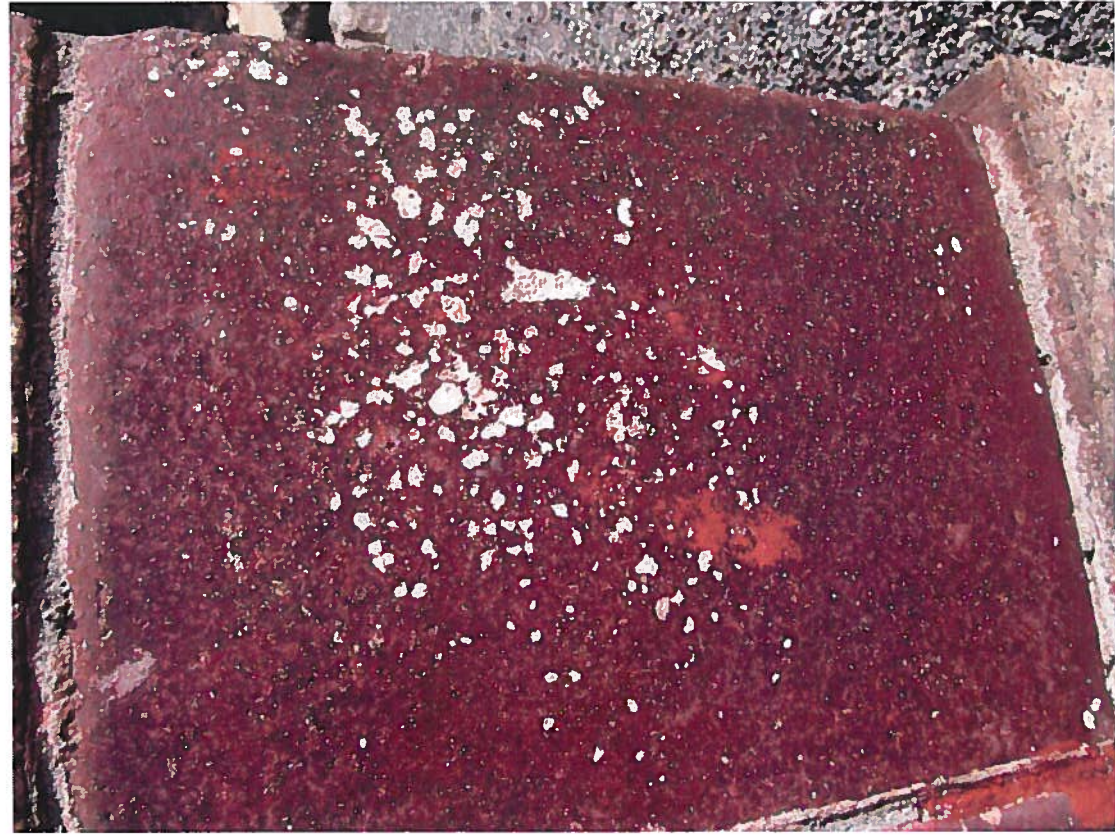
Obr. č. 15 a 16 Blok č. 2, západní strana. Poškozený povrch keramiky, popraskané keramické obložení, staré tmely.
