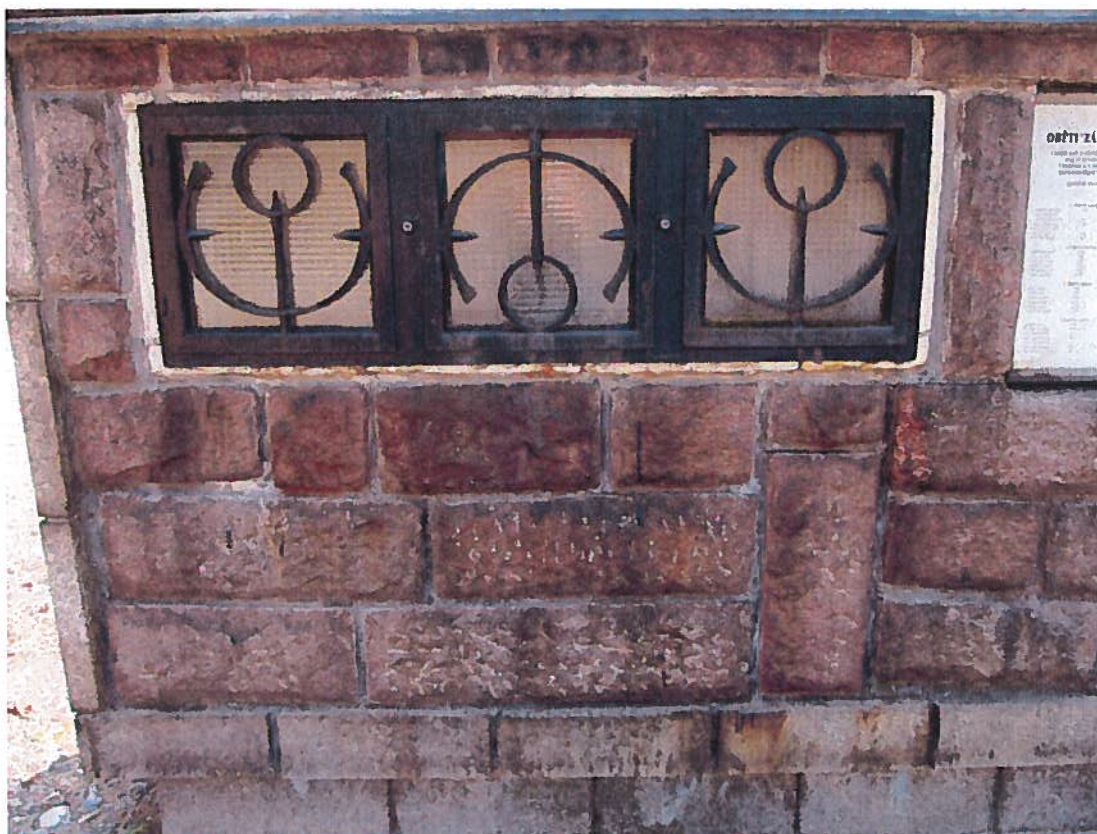
Obr. č. 4 Blok č. 1, severní strana. Kovová dvířka s drátěným sklem.
