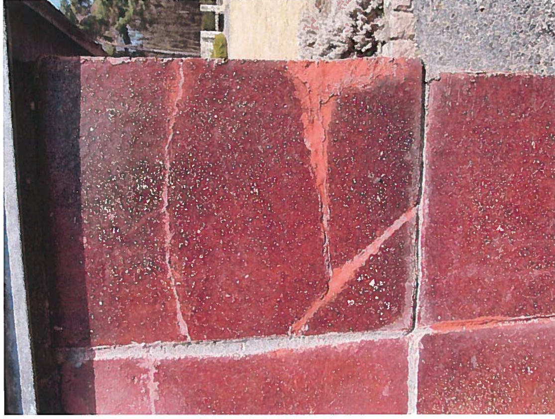
Obr. č. 15 a 16 Blok č. 2, západní strana. Poškozený povrch keramiky, popraskané keramické obložení, staré tmely.
