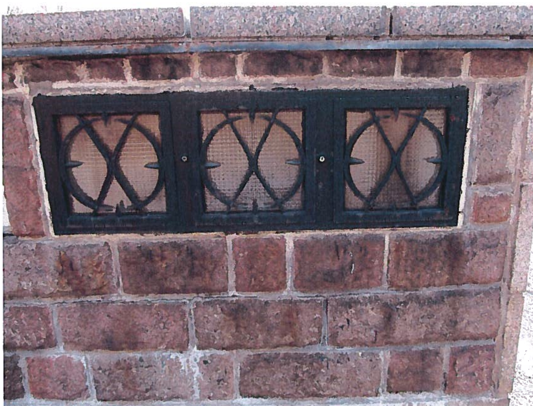
Obr. č. 14 Blok č. 2, severní strana. Kovová dvířka s drátěným sklem. Nevhodné spárování okolo dvířek.
