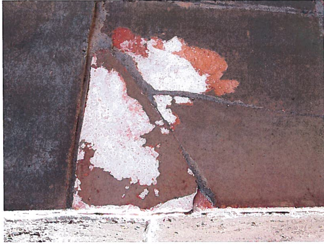
Obr. č. 7 a 8 Blok č. 1, východní strana. Poškozená svrchní část keramiky, praskliny keramického obkladu, nevhodné spárování.
