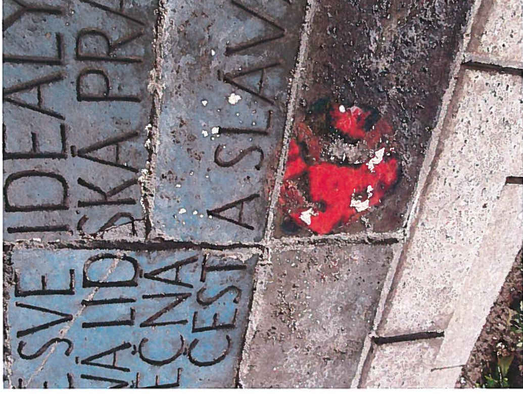
Obr. č. 5 a 6 Blok č. 1, jižní strana. Poškozená svrchní část keramiky, nevhodné spárování.
