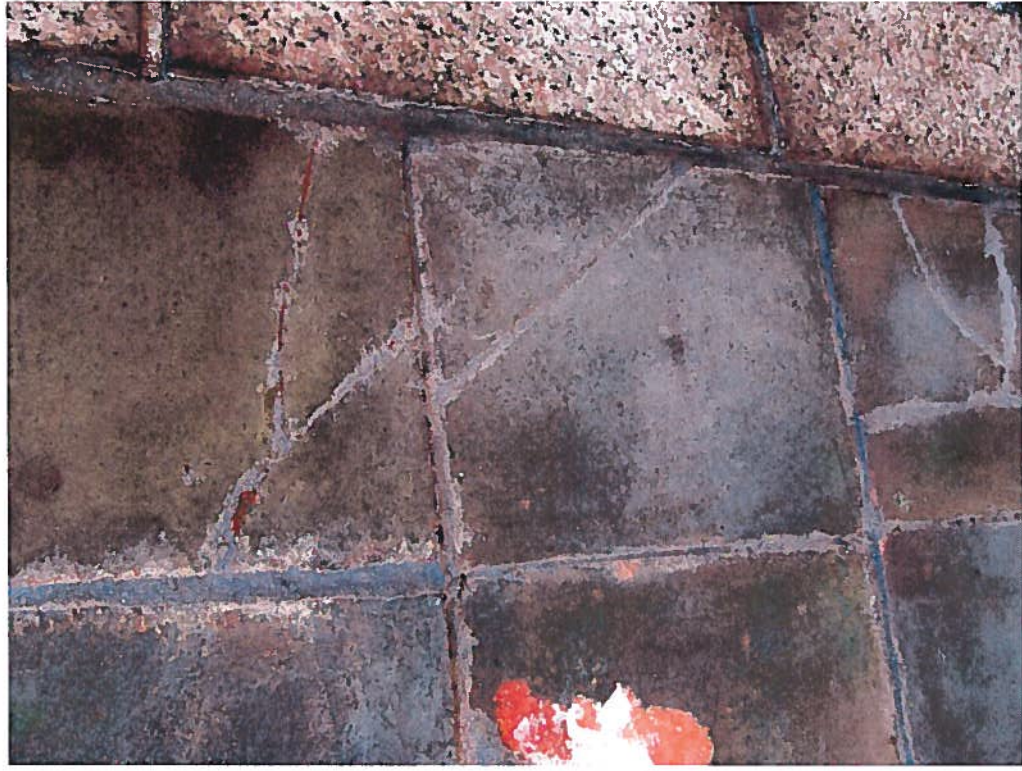
Obr. č. 9 a 10 Blok č. 1, východní strana. Praskliny keramického obkladu. Vypadané spárování horních žulových bloků.
