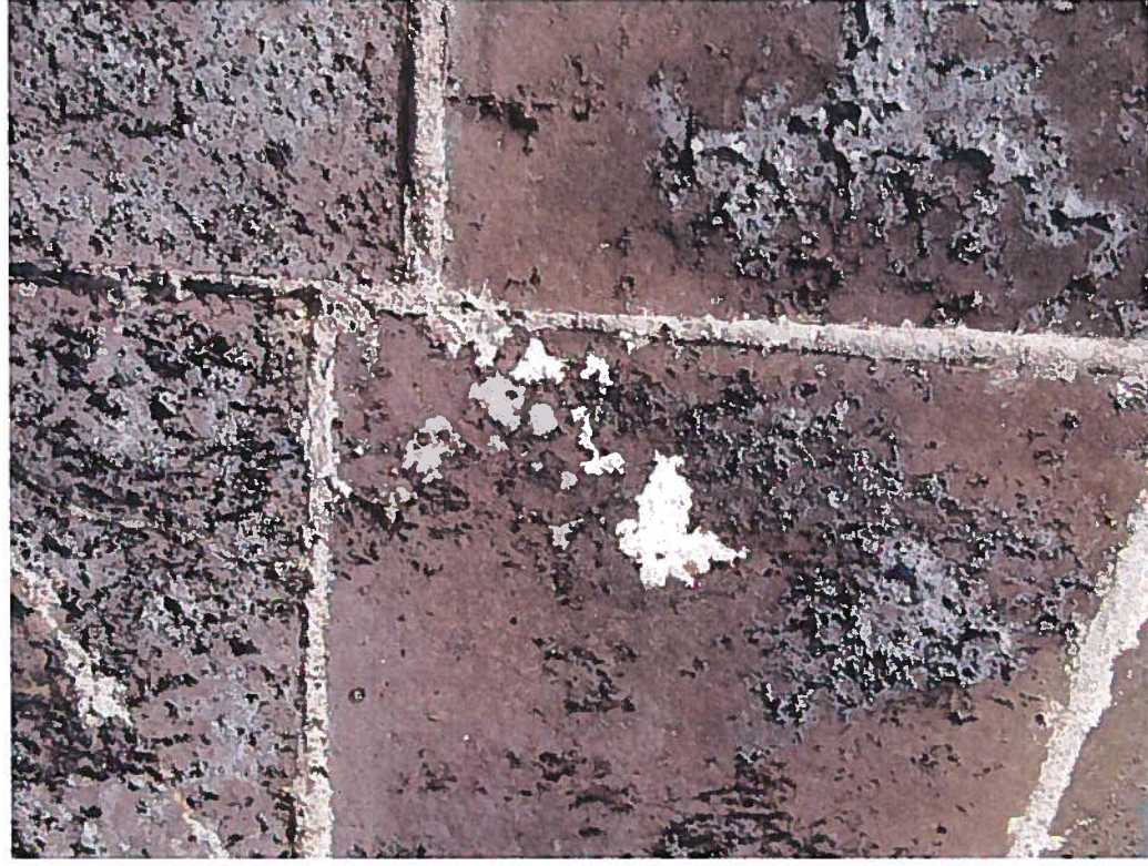
Obr. č. 5 a 6 Blok č. 1, jižní strana. Poškozená svrchní část keramiky, nevhodné spárování.
