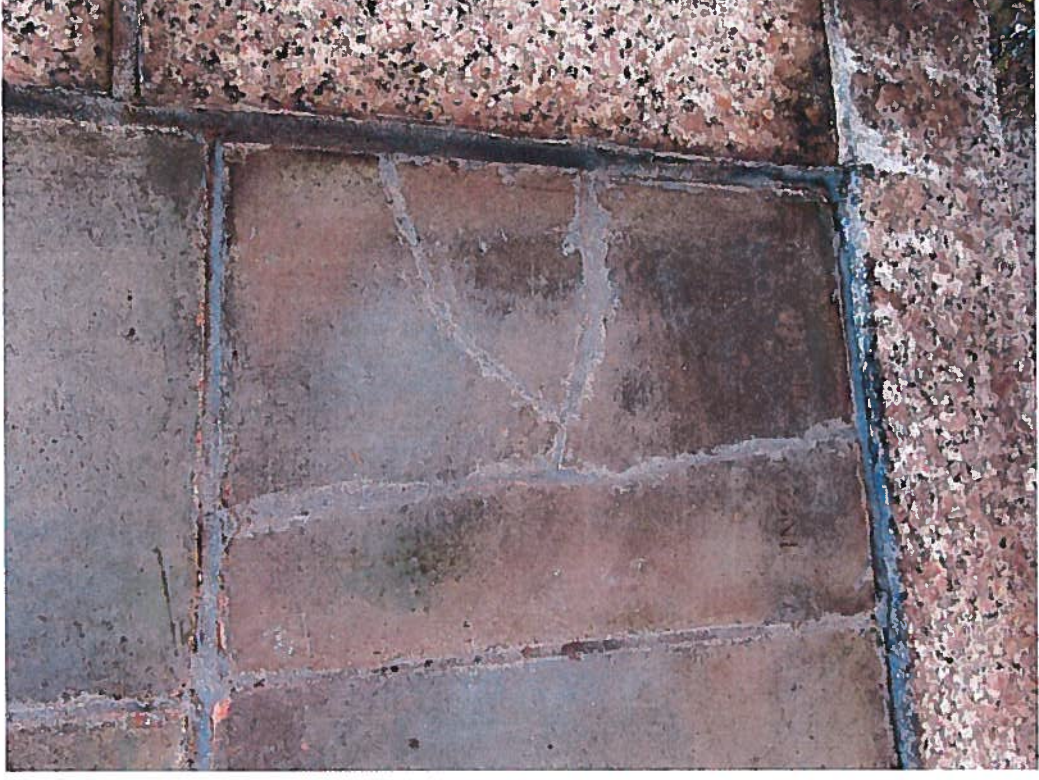
Obr. č. 7 a 8 Blok č. 1, východní strana. Poškozená svrchní část keramiky, praskliny keramického obkladu, nevhodné spárování.
