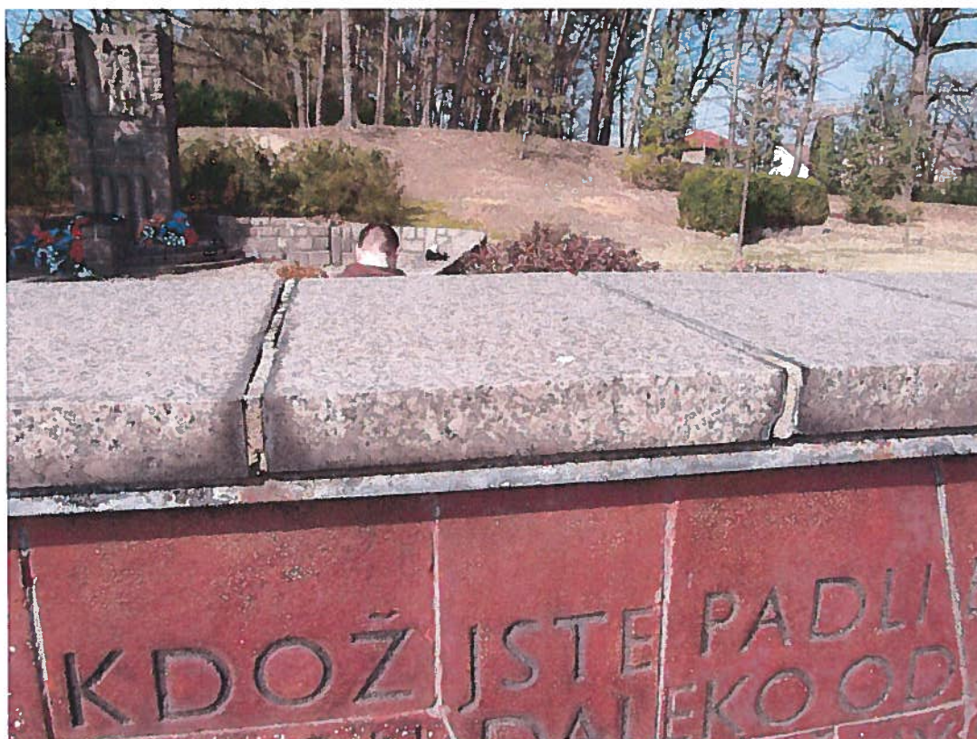
Obr. č. 19 Blok č. 2. Rozvolněné spárování horních žulových bloků. Zkorodovaná plechová stříška.
