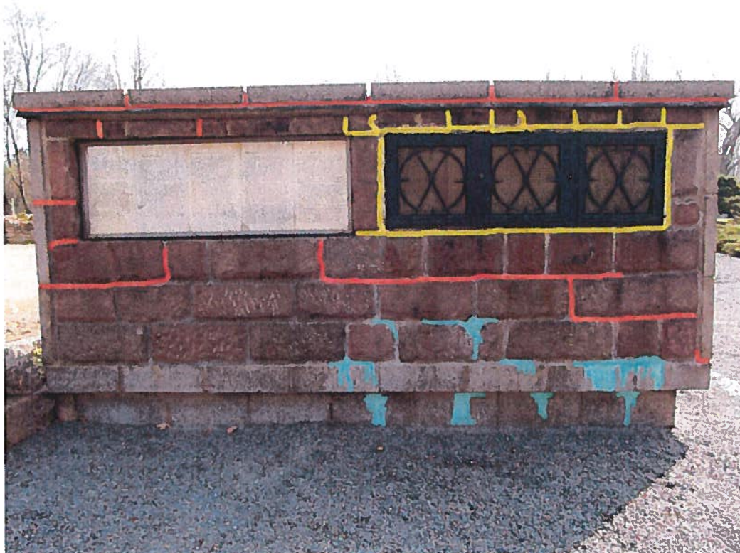
Grafické zakreslení poškození pietních bloků Blok č. 2, severní strana
