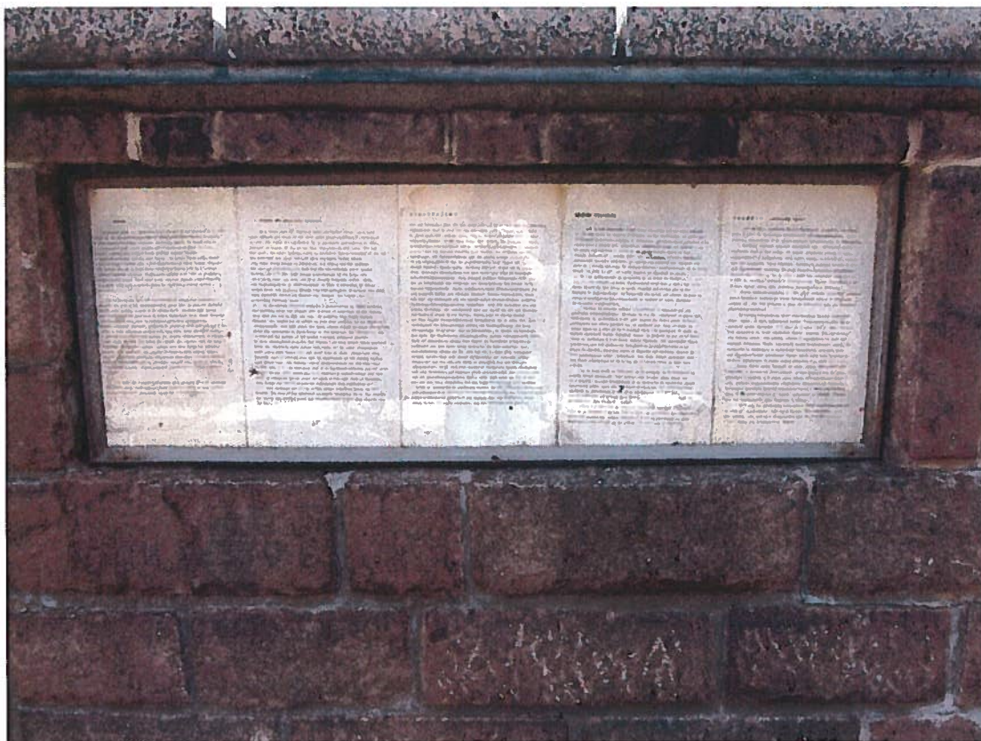
Obr. č. 13 Blok č.2, severní strana. Tabulka s hliníkovým rámem a plexisklem.
