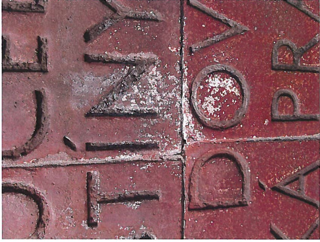
Obr. č. 17 a 18 Blok č. 2, jižní strana. Poškozený povrch keramiky, výkvěty síranových solí.
