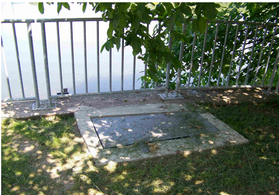
Vtokový objekt do vodního systému Tyršových sadů z Labe (manipulační šachta s osazeným vřetenovým šoupátkem).
