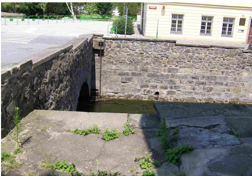
Manipulační objekt na Císařském náhonu v profilu Wernerova náměstí – propust hrazená dlužemi.
