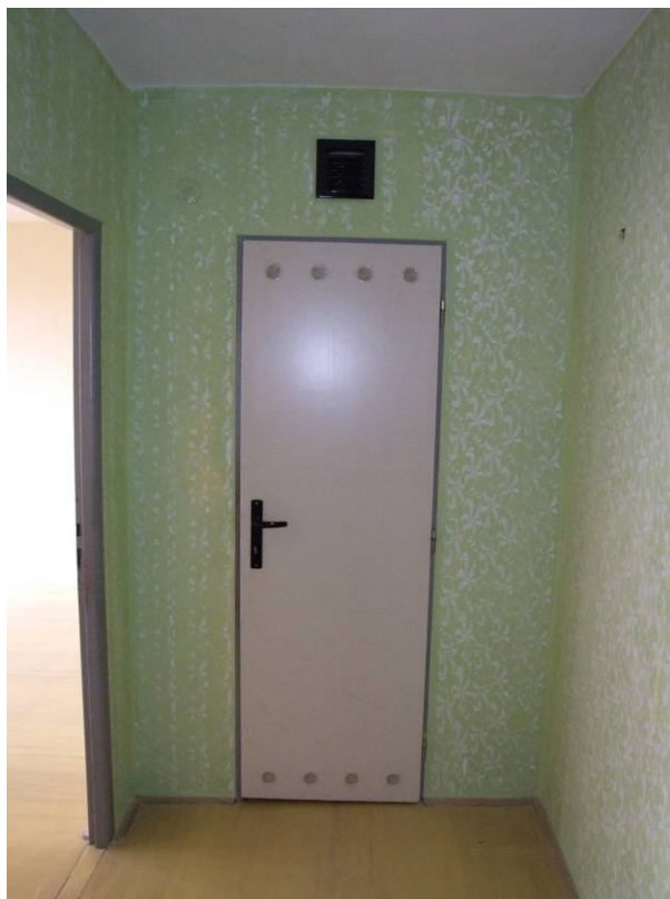
dveře do šatny, ventilační průduchy v křídle, otvor nad dveřmi
