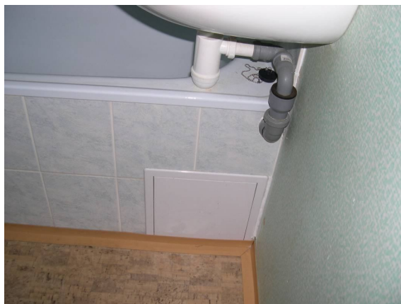
Revizní otvor do prostoru pod vanou
