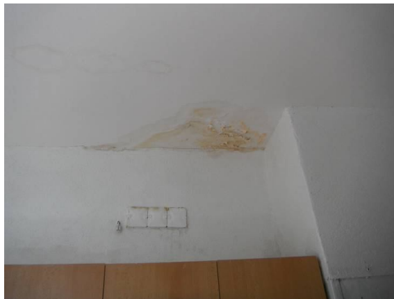
stopy vlhkosti na stropě nad kuchyňskou linkou
