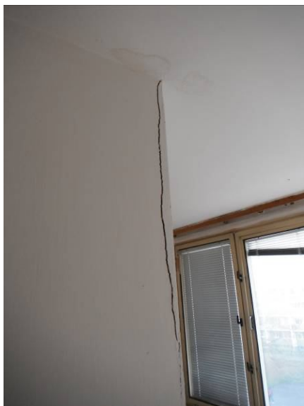
trhlina na čele zděné příčky – obložení sádkartonovou deskou přetažené přes čelo zděné příčky
