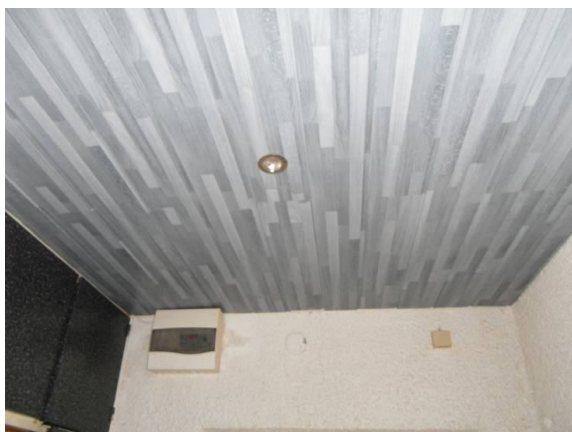
bytový rozvaděč + konstrukce podhledu
