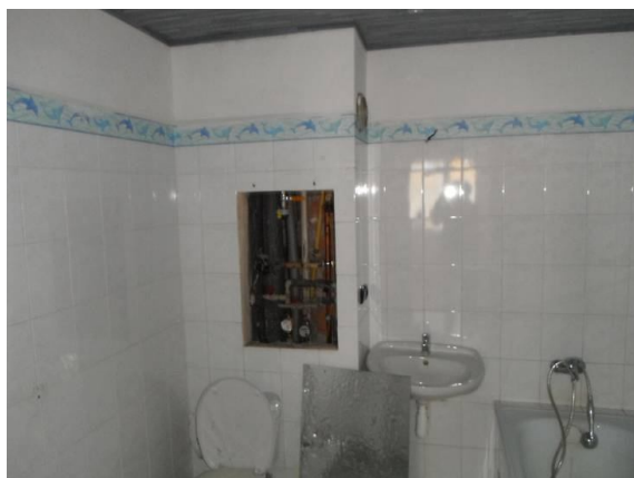
revizní otvor do instalační šachty
