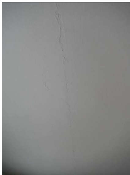
trhlina v omítce na stropě v ložnici m.č.05
