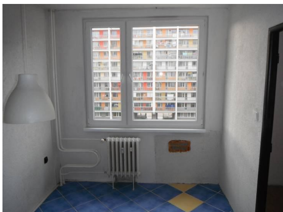
okno v kuchyni + ztmelené odvětrání demontované spíží skříně
