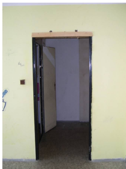
Pohled z obývacího pokoje do předsíně – ocelová zárubeň bez dveřního křídla
