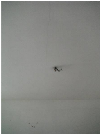
na stropě trhliny v omítce
