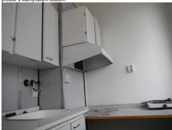
kuchyňská linka s digestoří (zákryt napojení odtah par)
