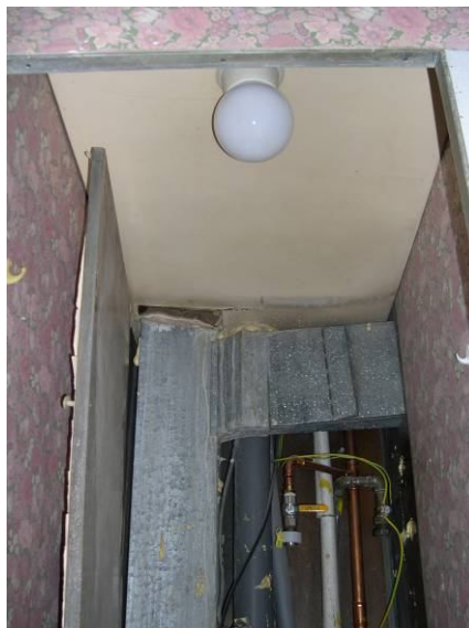
konstrukce podhledu včetně osvětlení na WC + rozvody v instalační šachtě
