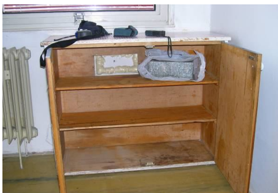
spízní skříň – odvětrání zaslepeno
