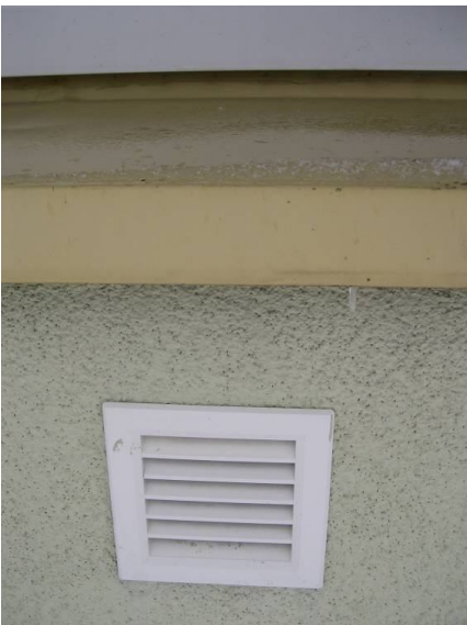
plastová větrací mřížka ze strany exteriéru na odvětrávacím zařízení
