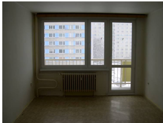
vstupu na bytovou ložnici + dilatační kus na stoupacím potrubí UT
