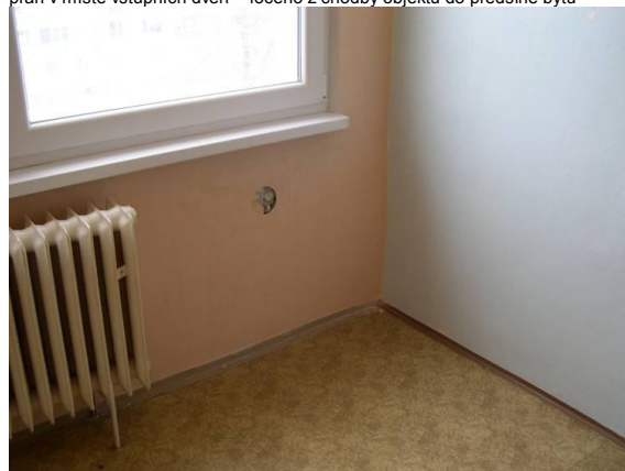
zbytky větrací mřížky ze strany interiéru na odvětrávacím zařízení, které původně sloužilo k odvětrání
