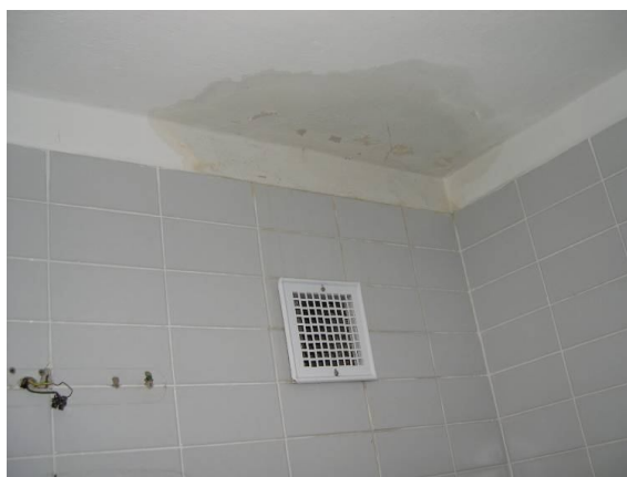
odvětrání prostoru koupelny + stopy po zatékání z bytu horního patra
