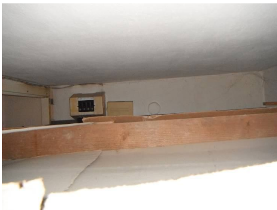
bytový el. rozvaděč nad dřevěnou konstrukcí podhledu
