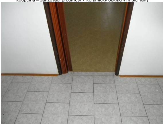
vstup do ložnice m.č.06 z předsíně – napojení keramické dlažby na PVC
