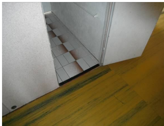
vstup do koupelny z předsíně – ocelový profil v místě prahu
