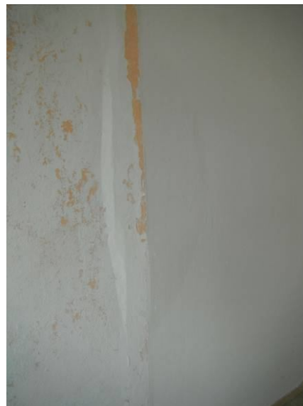
nesoudržná omítka k podkladu (stěnový panel) v obývacím pokoji
