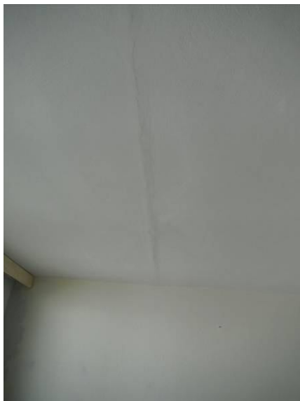
trhlina v omítce na stropu v ložnici m.č.06 – trhlina v místě styků panelů
