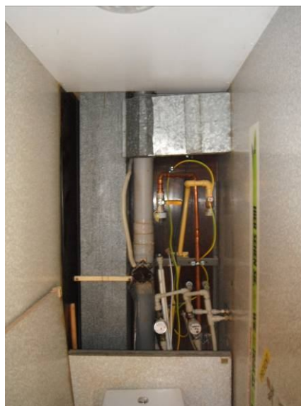
instalační šachta v prostoru za WC
