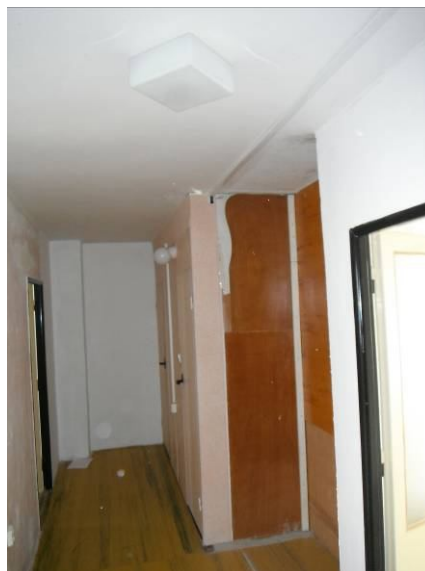
prostor předsině – umakartové bytové jádro + zbylé obložení stěn po odstranění vestavěné skříně
