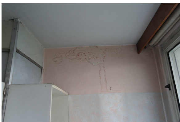
stopy zatékání na stěně v kuchyňském koutě
