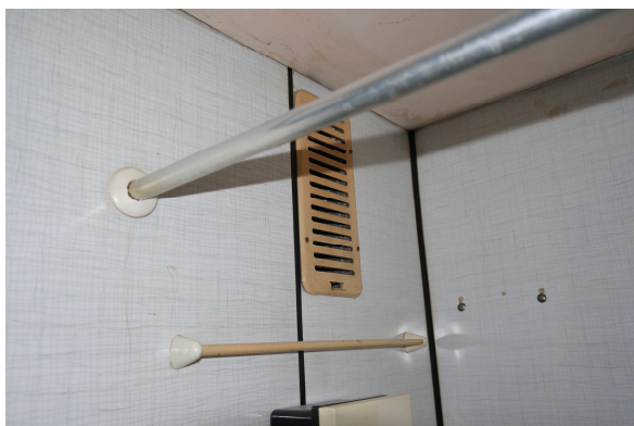
odvětrání prostoru koupelny
