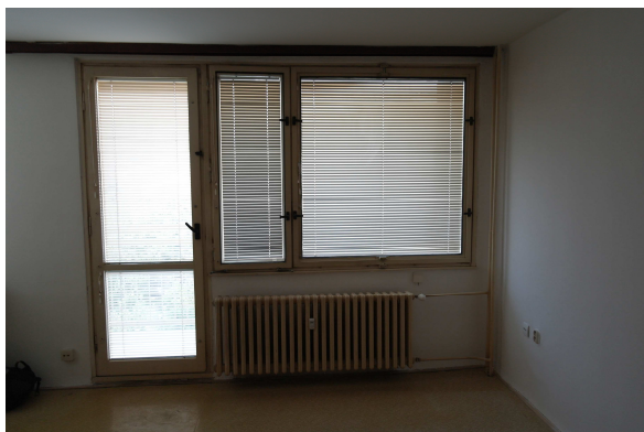
žebrový radiátor v obývacím pokoji + okenní sestava
