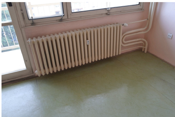
žebrový radiátor v obývacím pokoji + dilatační kus na stoupačkách UT
