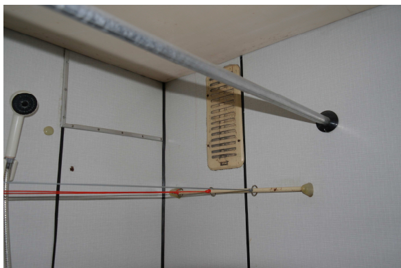
odvětrání prostoru koupelny + konstrukce podhledu
