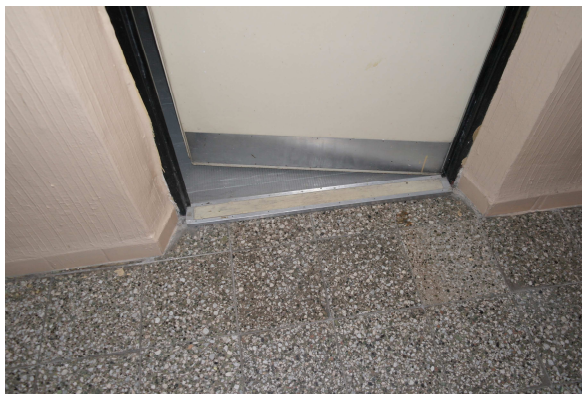
vstup do bytu – provedení dveřního prahu
