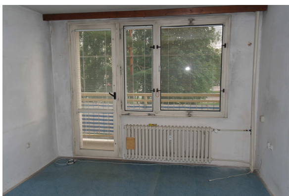
okenní výplň v obývacím pokoji – lodžiová sestava
