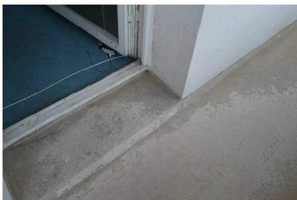
provedení prahu balkonových dveří ze strany exteriéru
