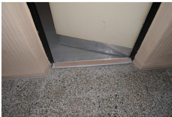
vstup do bytu – provedení dveřního prahu
