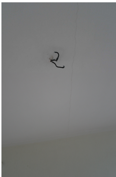
trhliny na stropní konstrukcy – na styku panelů
