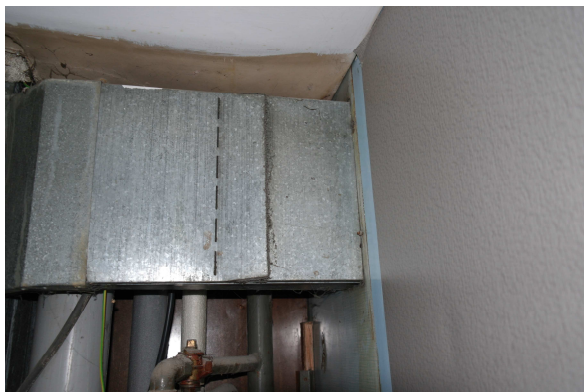
rozvod VZT v instalační šachtě – ze strany koupelny zaslepeno
