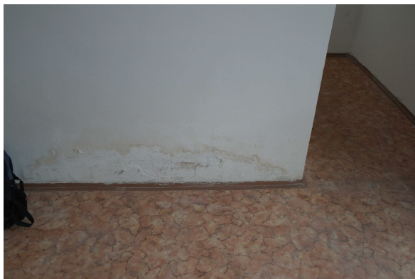
projevy vlhkosti na stěně mezi obývacím pokojem a koupelnou
