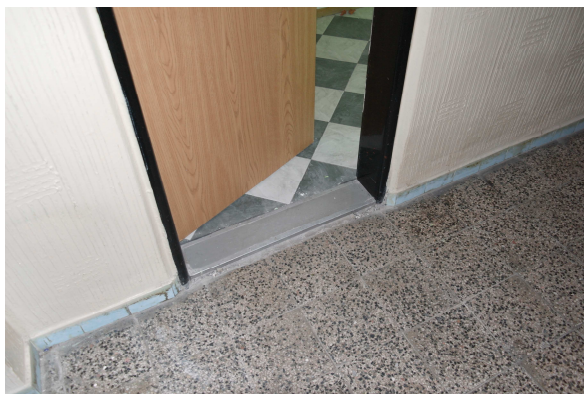
vstupní dveře do bytu – provedení prahu
