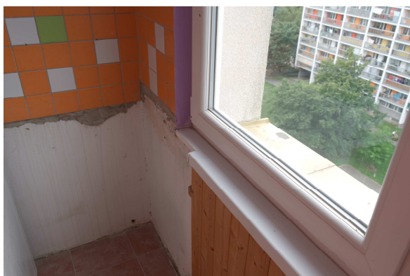
úprava parapetního profilu + dřevěný obklad
