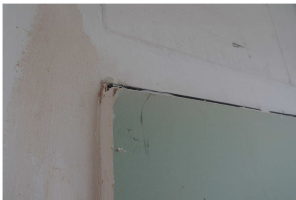
provedení zaslepení dveřního otvoru do komory ze společné chodby
