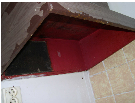
digestoř - odtah par nad sporákem
