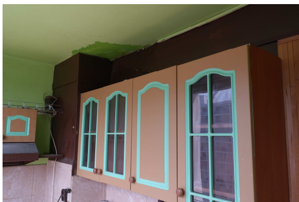
stopy vlhkosti na stropě nad kuchyňskou linkou
