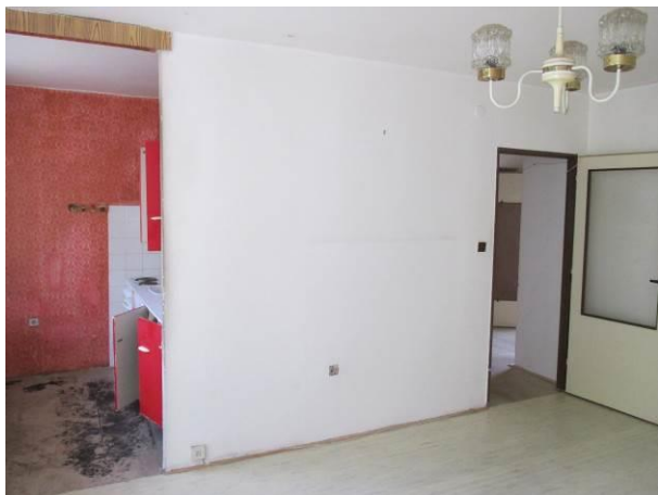
Dělicí příčka mezi obytným prostorem a bytovým jádrem.
