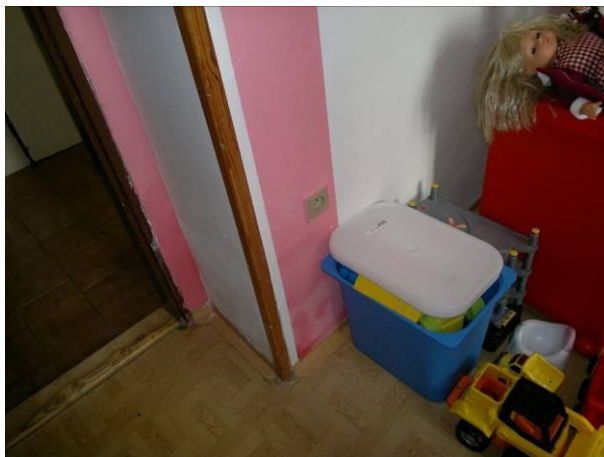
vlhkost na střední stěně mezi místnost 10A a 05
