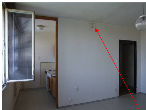
pohled na stěnu s dřevěnou obložkou a stopami po zatečení
