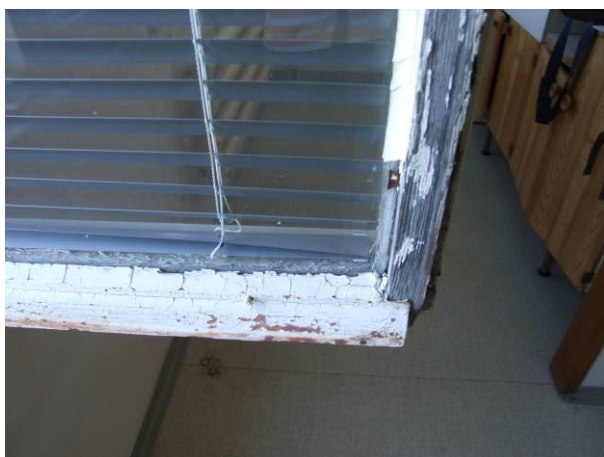
detail poškozeného okenního rámu
