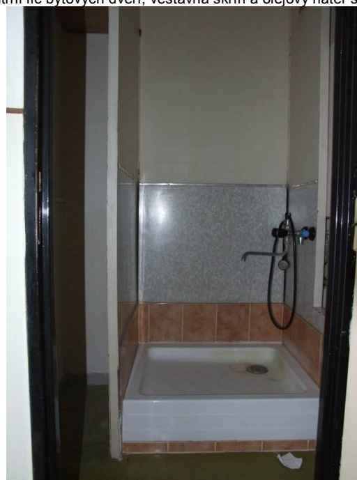
podezděná sprchová vanička s keramickým a umakartovým obkladem
