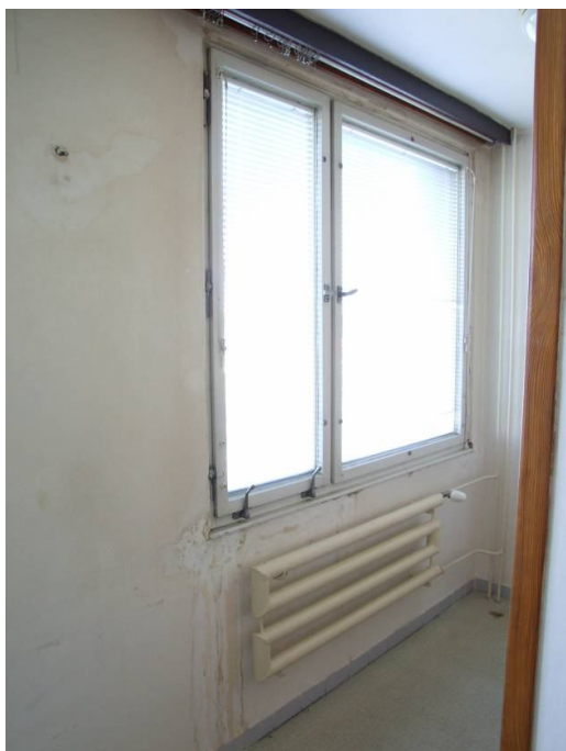
okenní výplň v kuchyni + stopy po průniku srážkových vod
