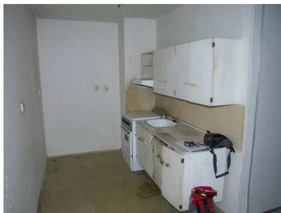
kuchyňská linka v dezolátním stavu stopy po havárii vodovodního řádu, nebo kanalizace
