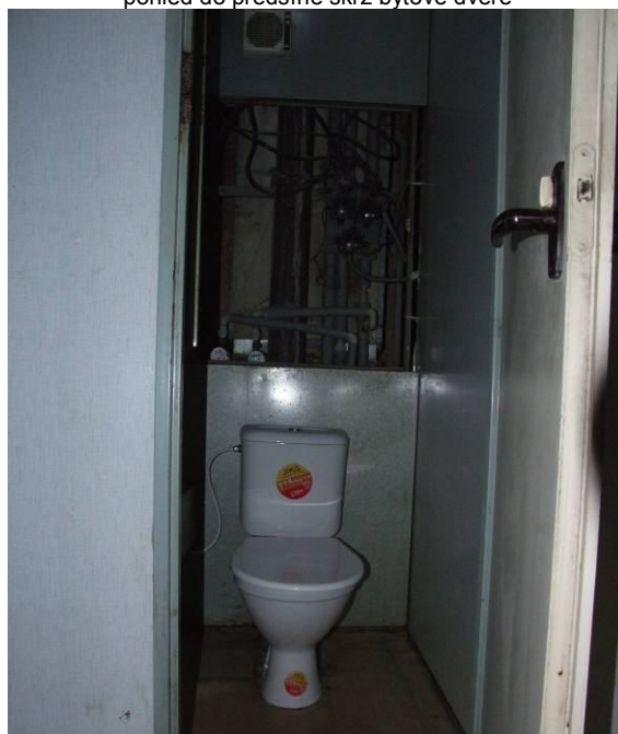
toaletní mísa v provedení kombi, podlaha z PVC a plechová zadní stěna mezi WC a instalační šachtou
