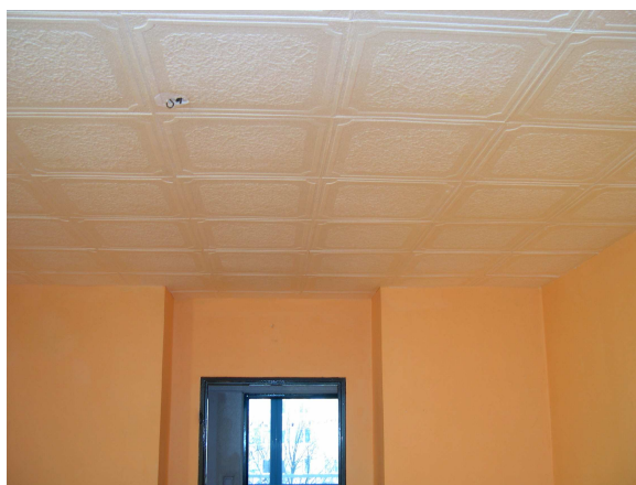
kazetový polystyrénový podhled v obývacím pokoji
