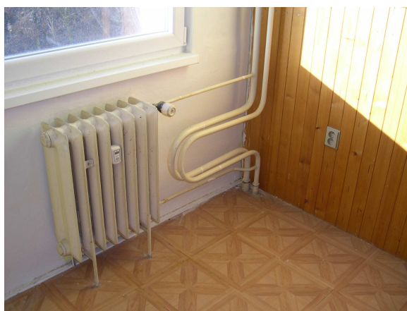
radiátor + stoupačka UT s dilatačním kusem a dřevěný obklad v kuchyni
