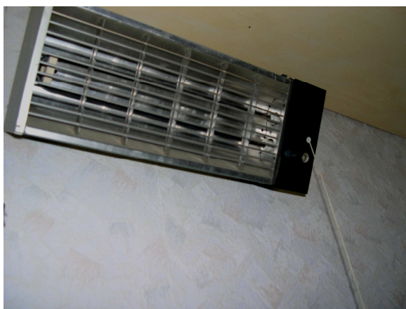
infrazářič na stěně v koupelně
