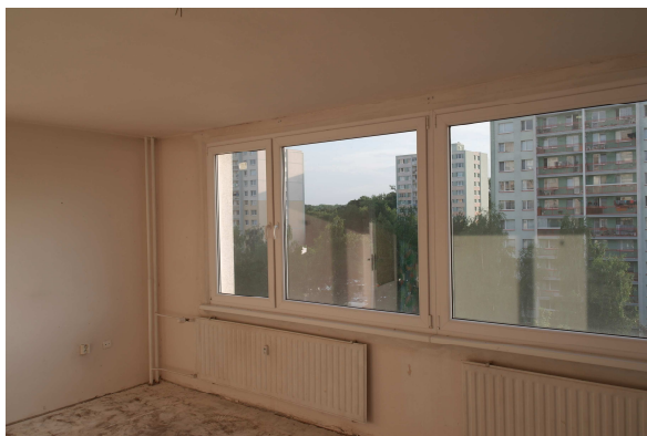
okenní výplň v obývacím pokoji – okenní sestava dvou dvoukřídlových oken
