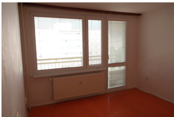
okenní výplň v obývacím pokoji – lodžiová sestava s balkonovými dveřmi
