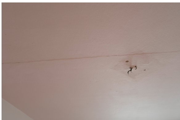
trhlina v omítce na styku panelů na stropě
