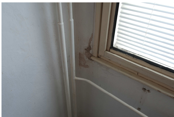
poškozená omítka v místě ostění okna v ložnici m.č. 07
