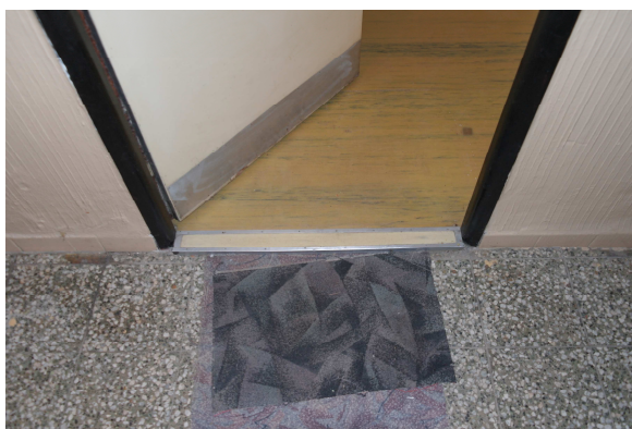
vstup do bytu – provedení dveřního prahu
