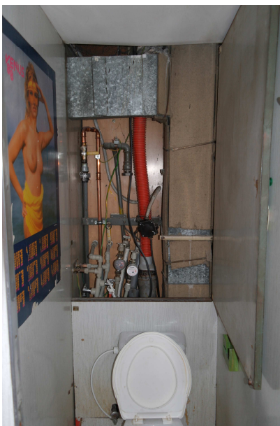
instalační šachta – foceno z prostoru WC
