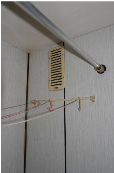
odvětrání prostoru koupelny + konstrukce podhledu
