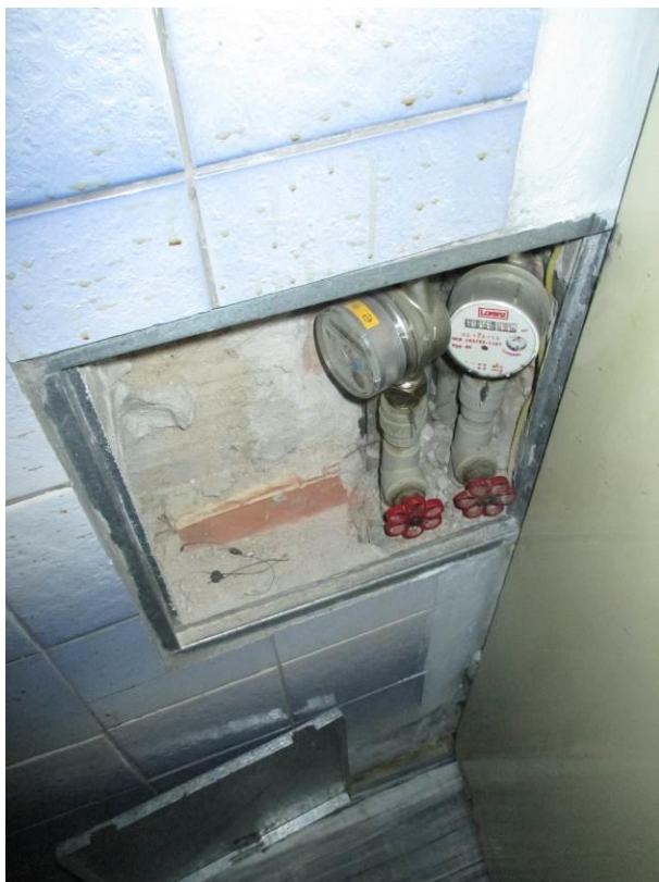
Revizní otvor pro přístup k vodoměrům v místnosti WC.
