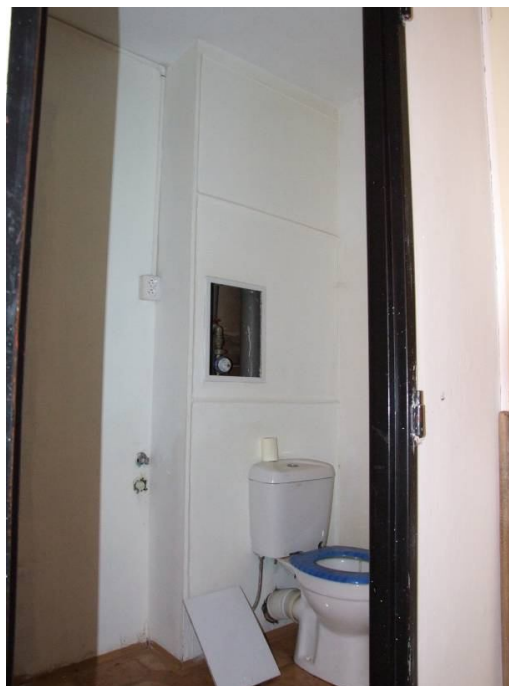
toaleta v provedení kombi, umývadlo a vana demontovány, úprava zadní stěny a opláštění šachty SDK konstrukcí
