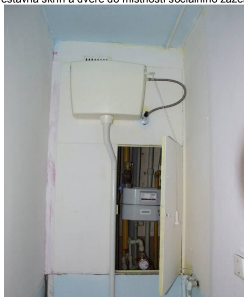
pohled do instalační šachty s plynoměrem
