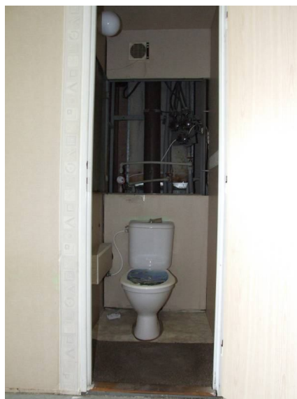
WC s kombinovaným klozetem a pohledem do instalační šachty
